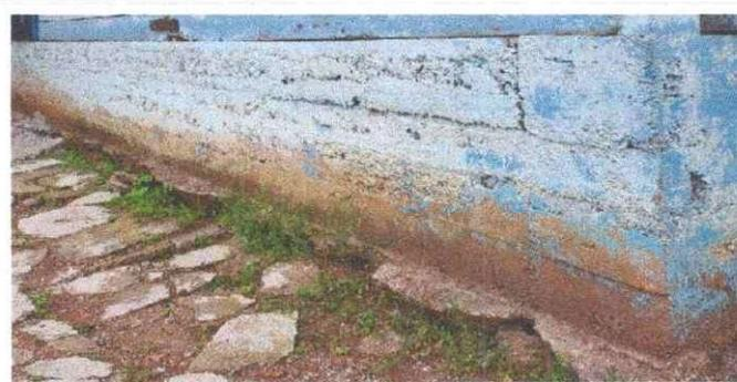
Foto 5: REPARACIÓN DE REPELLO Y CERNIDO DE LA BASE DE BLOCK DE LAS CUATRO PAREDES DEL AULA 1.
